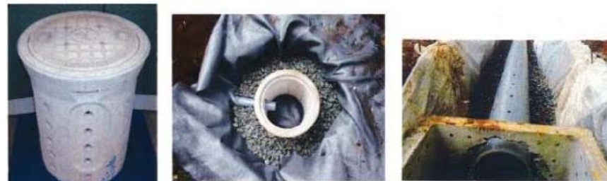
雨水浸透ますの例
