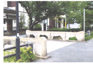
稲荷橋(高欄と橋面の改修)
