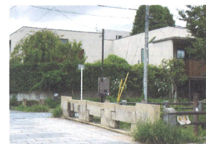
御嶽橋(高欄と橋面の改修)
