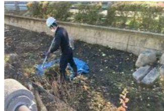
真冬の川床の清掃作業
