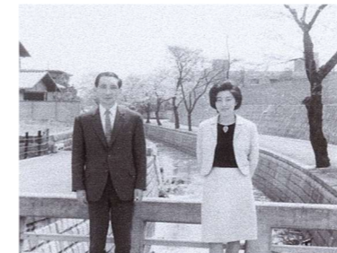
③1965年(御嶽橋から下流を見る)
